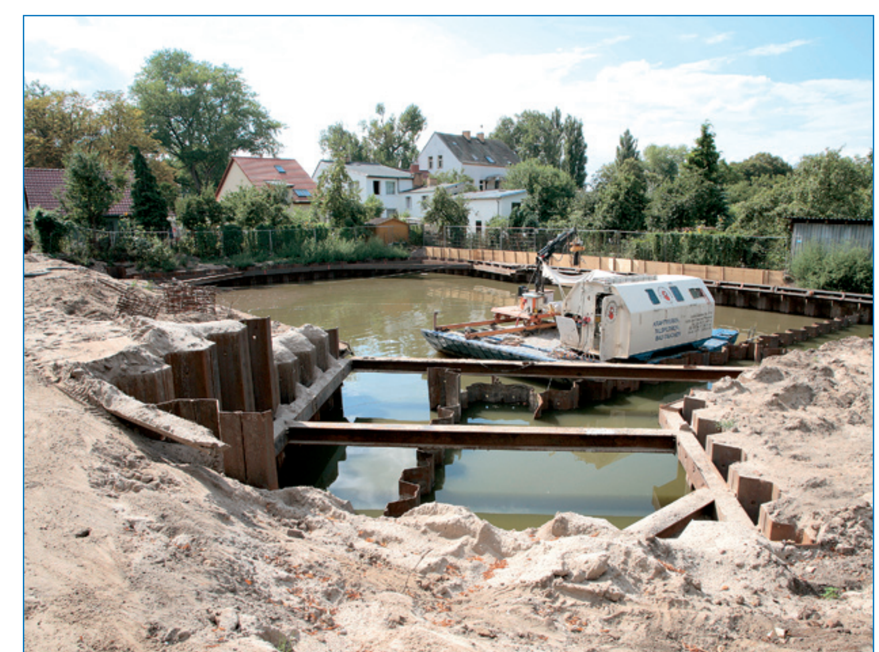
Vorbereitungen für die Unterwassersohle.
