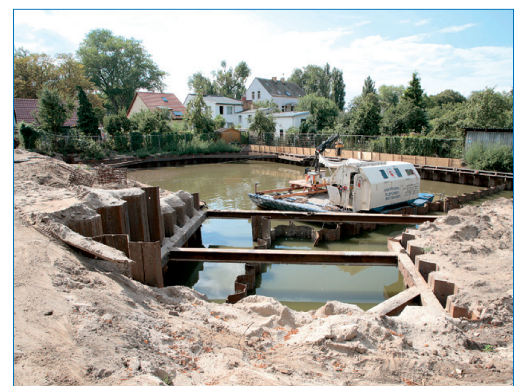
Vorbereitungen für die Unterwassersohle.
