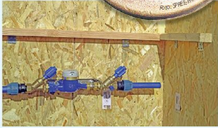
2 Auf den Winkeln werden entsprechend der Grubenmaße zugeschnittene Hölzer platziert. Sie dienen als Auflage für die Dämmung.
