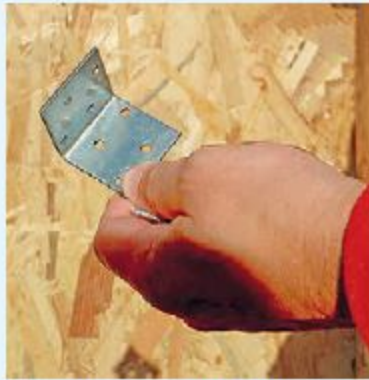
1 An den Seiten des Betonschachtes ininigem Abstand über dem Wasserzähler einfache Winkel anschrauben. Sie dienen als Auflage.
