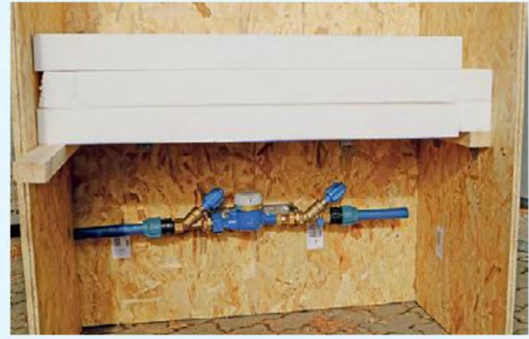
3 Fertig: Auf die Hölzer werden etwa acht Zentimeter starke Styroporplatten aus dem Baumarkt gelegt. Wer Alu-Streben verwendet, muss etwas mehr Geld ausgeben – dafür halten sie länger. Fotos (3): I. Müller
