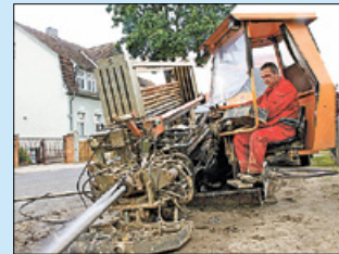
Insgesamt zwei Kilometer Leitungen sollen mit dem Spezialgerät ohne viel Aushebens verlegt werden.
