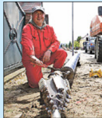
So sieht er aus, der Bohrkopf für den unterirdischen Vortrieb.
