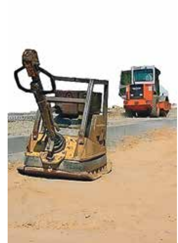
Wo die Rüttelplatte auftaucht, ist Baustellenungemach bald vorbei.
