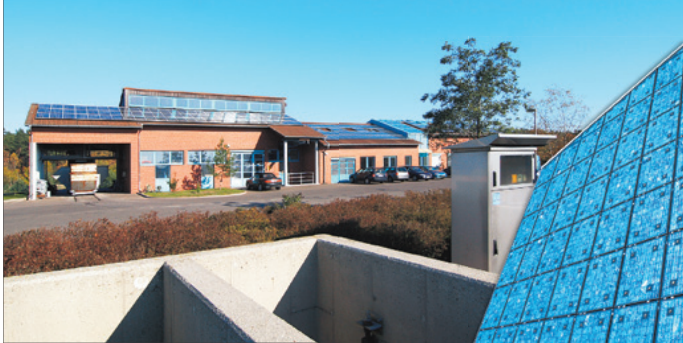
Die Kläranlage Fürstenwalde ist nun auch in energetischer Hinsicht auf modernstem Niveau – die Solarzellen auf dem Dach beweisen es.
