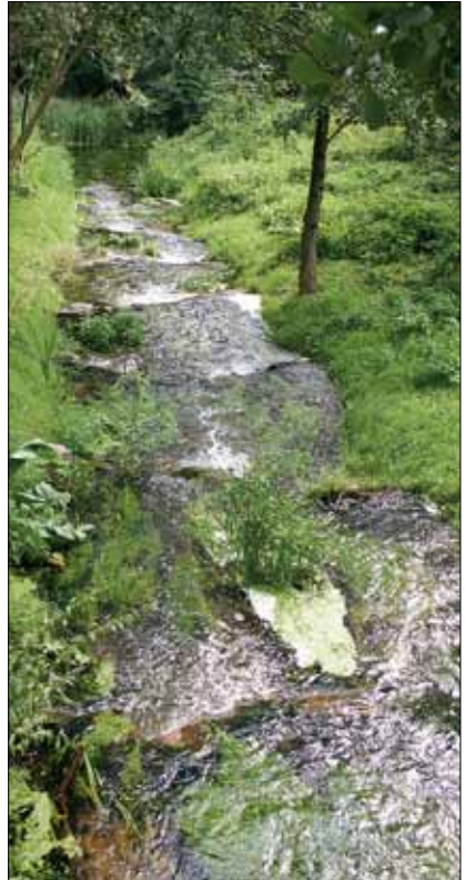
Zum guten ökologischen Zustand gehört die Durchgängigkeit der Fließgewässer. Hier ersetzt eine Fischtrappe ein früheres Wehr.
