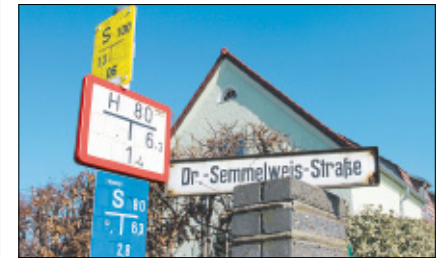
Die Schilder zeigen: Leitungen sind da. Doch hier in Fürstentwalde-Süd bedarf das Trinkwassernetz einer umfassenden Sanierung.
