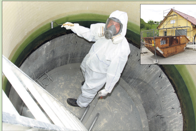
Der Container vor der Kläranlage – ein stummer Zeuge der Bauarbeiten (kl. Bild). Der Beton des Sandfangs ist zum Schutz vor Korrosion mit glasfaserverstärktem Kunststoff ausgekleidet. Uwe Eichler von der Spezialfirma Amitech laminiert diese Deckschicht.
