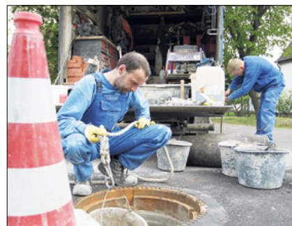
An der Ecke Käthe-Kollwitz-/Marchlewskistraße: Nils Burckhardt (links) und Peter Gehlsdorf bei der Schachtsanierung nach abgeschlossener Schlauchrelining.
