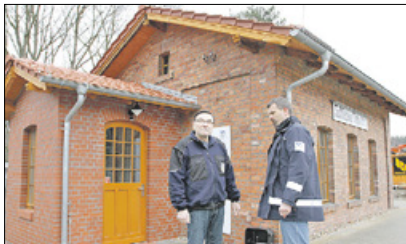
Schleuse Kersdorf – dieses Haus birgt Geschichte aus Jahrhunderten.
