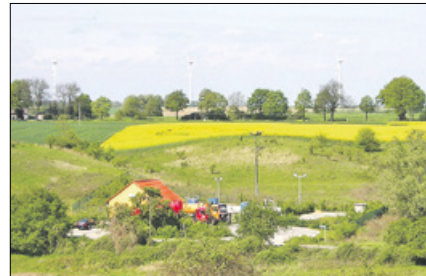
Die Lebuser Kläranlage wurde unlängst vom ZVWA modernisiert.
