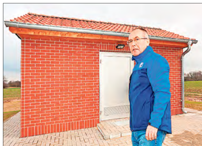
ZVWA-Bauleiter Klaus Fischer vor der voll automatisierten Druckerhöhungsanlage, in der vier leise und energieeffiziente Pumpen plus ein Pufferbehälter ihren Dienst verrichten. Foto: SPREE-PR/Maihorn
