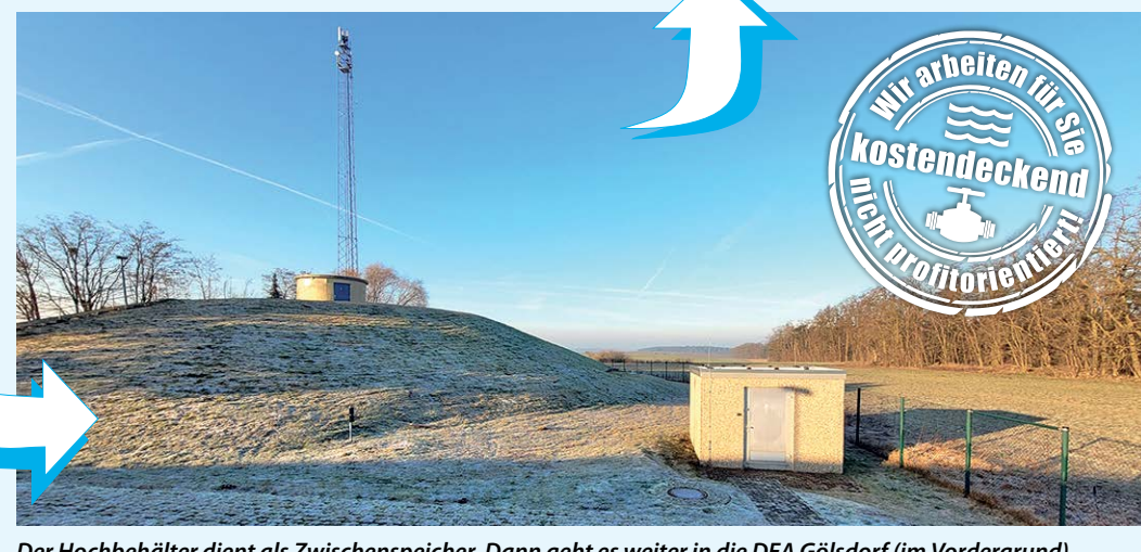
Der Hochbehälter dient als Zwischenspeicher. Dann geht es weiter in die DEA Gölsdorf (im Vordergrund). Die Pumpen in der DEA Gölsdorf sorgen für den benötigten Druck in Gölsdorf und Schönfelde. Fotos: ZVWA
