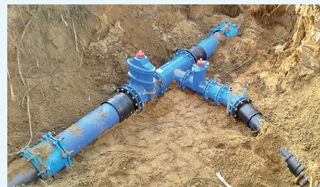
Von der 2023 im Spülbohrverfahren verlegten Transportleitung DA90 (90 mm Außendurchmesser) ist oberirdisch nichts mehr zu sehen.
