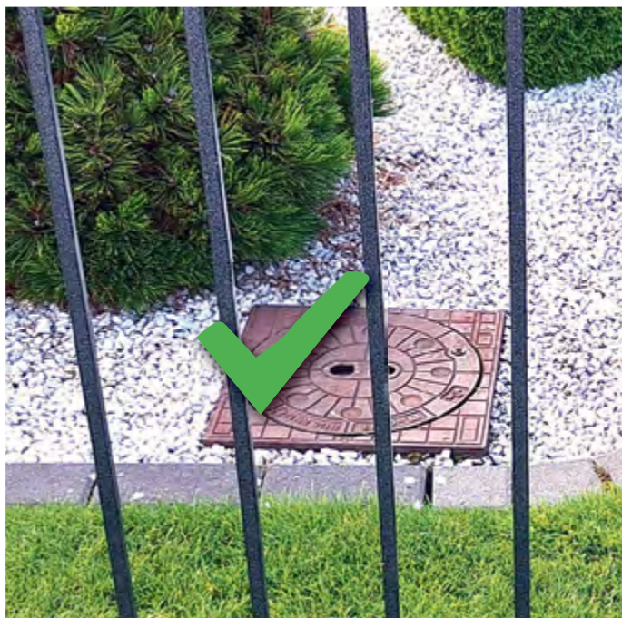
Der Revisionsschacht muss nicht nur optimal positioniert, sondern zugleich immer zugänglich sein.
