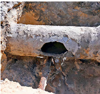
Die zerstörte Regenwasserleitung.
