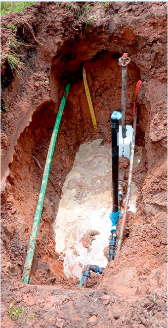
Die enge Baugrube und zahlreiche Fremdmedien erfordern präzises Arbeiten
