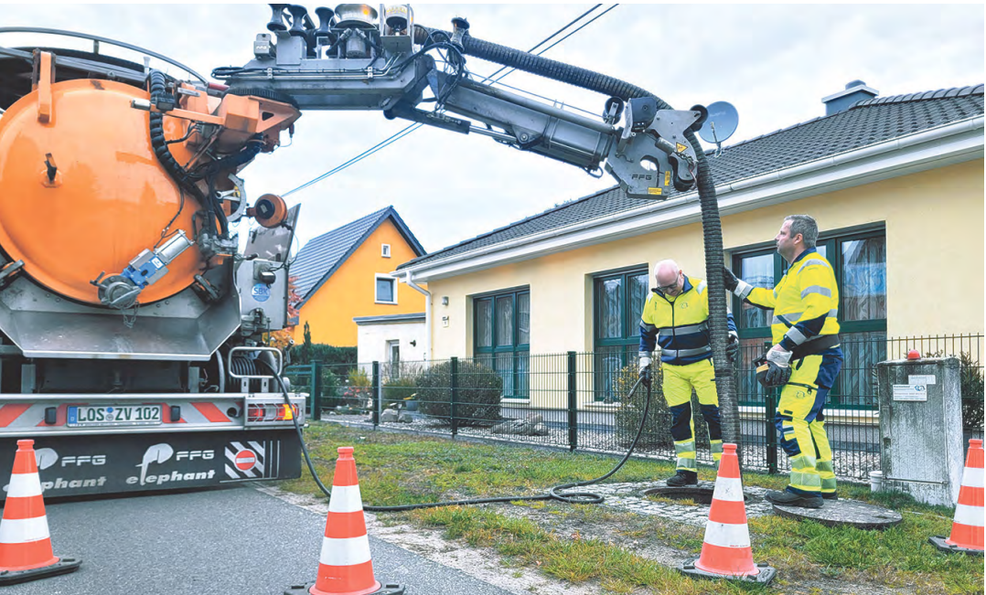
Die Kollegen aus dem Bereich Kanalnetz beim Reinigen einer Druckentwässerung.
