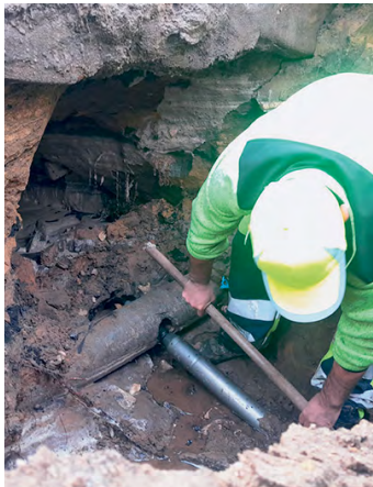
In Fürstenwalde, Breite Straße, beschädigt eine Erdrakete diese Trinkwasserleitung und steckt noch im Rohr.
