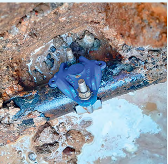
Die blaue Schelle verschleißt den Riss und stellt die Dichtheit wieder her.
