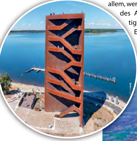
Der „Rostige Nagel“ ragt an der Mündung des Sornoer Kanals zum Sedlitzer See in den Himmel.
