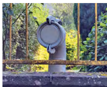
Ein freier Zugang zum Ansaugstutzen sorgt für eine sichere und zügige Entsorgung.
