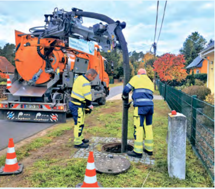
Auch Fettablagerungen in Druckentwässerungen oder Abwassergruben müssen aufwendig mit Spezialtechnik entfernt werden. Foto: ZVWA/Wilhelm
