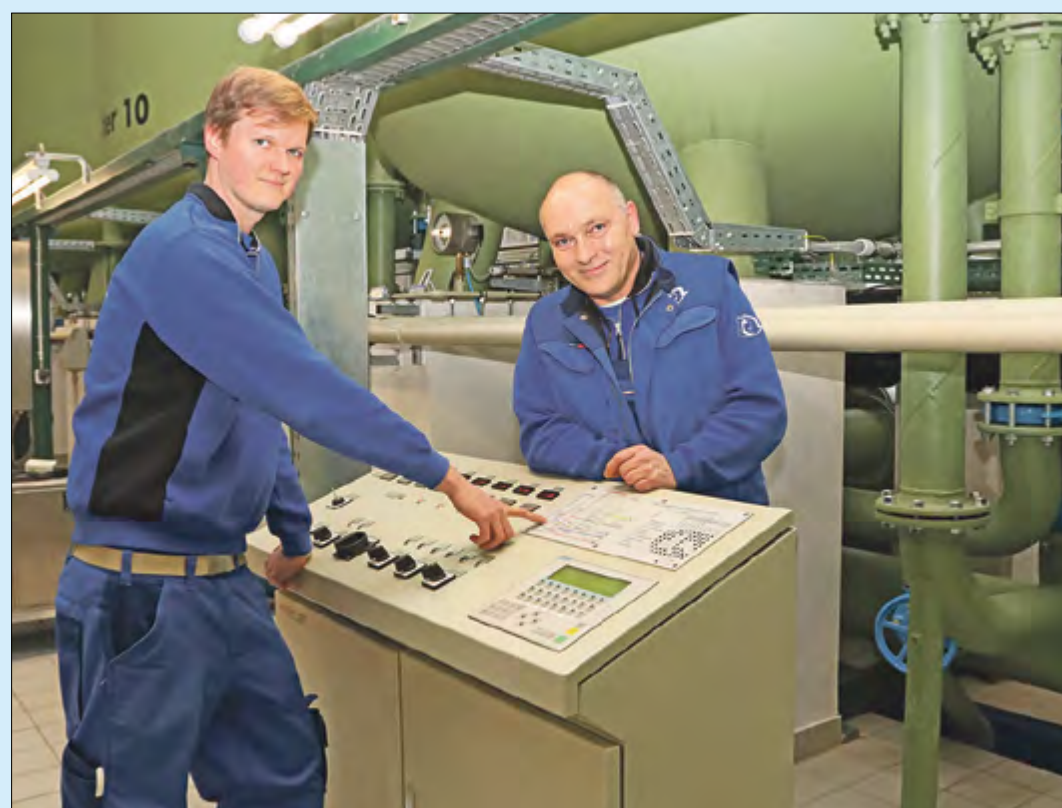
Auch die Arbeit an den modernen Anlagen des ZVWA – natürlich unter Anleitung erfahrener, freundlicher Kollegen – gehört zu den Aufgaben der Auszubildenden. Foto: SPREE-PR/Petsch
