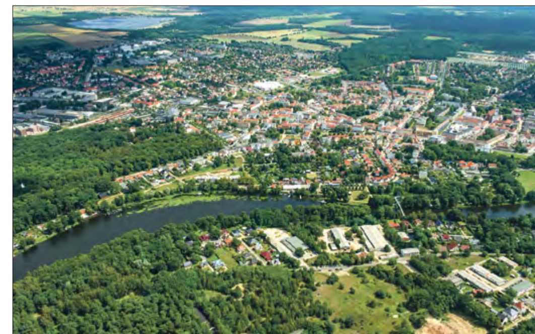
Auch in Fürstenwalde soll gebaut werden. In der Lindenstraße steht die Erneuerung der Trinkwasserleitungen auf dem Plan. Foto: Region@See/Stadt Fürstenwalde/Spre
