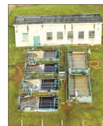
2021 sollen die Bauarbeiten auf der Kläranlage Heinersdorf beginnen. Foto: SPREE-PR/Petsch
